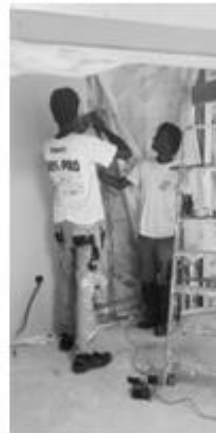
Installation de placo dans la partie atelier
