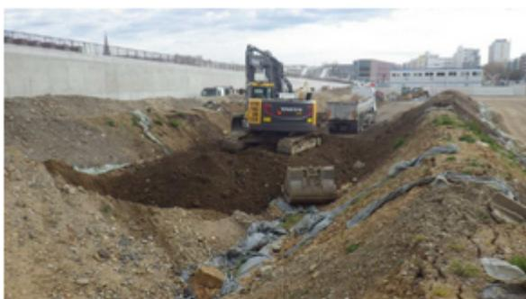
En juin, un bateau de 4500 tonnes a acheminé, en deux trajets, la terre jusqu'à Arcachon, où un centre de traitement a procédé à un lavage par criblage et d'un tri, pour que les matériaux puissent être réutilisés par la filière BTP. La voie des mers a permis de réduire le bilan carbone puisque le bateau a remplacé
